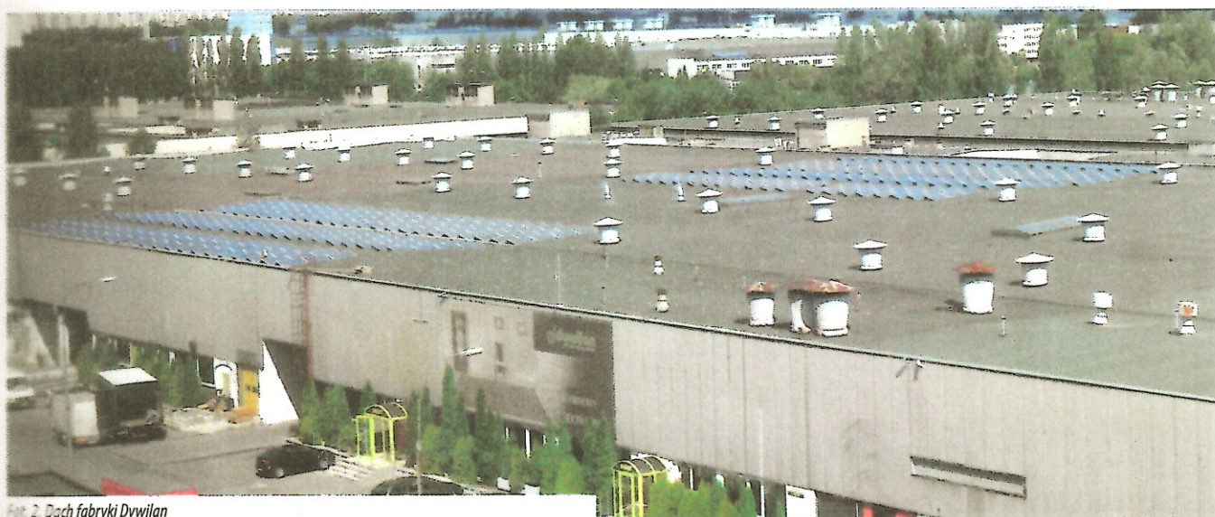
Fot. 2. Dach fabryki Dywilan
